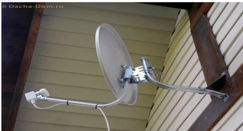
Рисунок 2: Азимутально-угломестный подвес антенны
